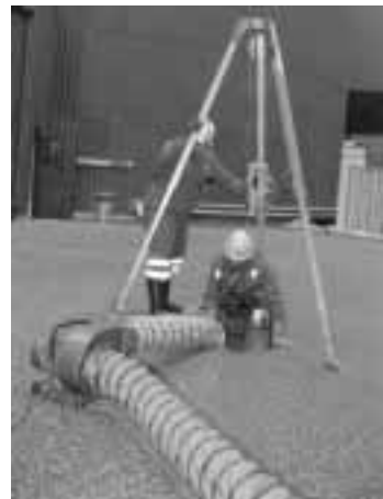
Beim Einsteigen in einen Schacht ist Alleinarbeit verboten. Denn im Notfall (Erstickengefahr!) ist sofortige Hilfe nötig. Die einsteigende Person muss dauernd von einer zweiten Person überwacht werden.
